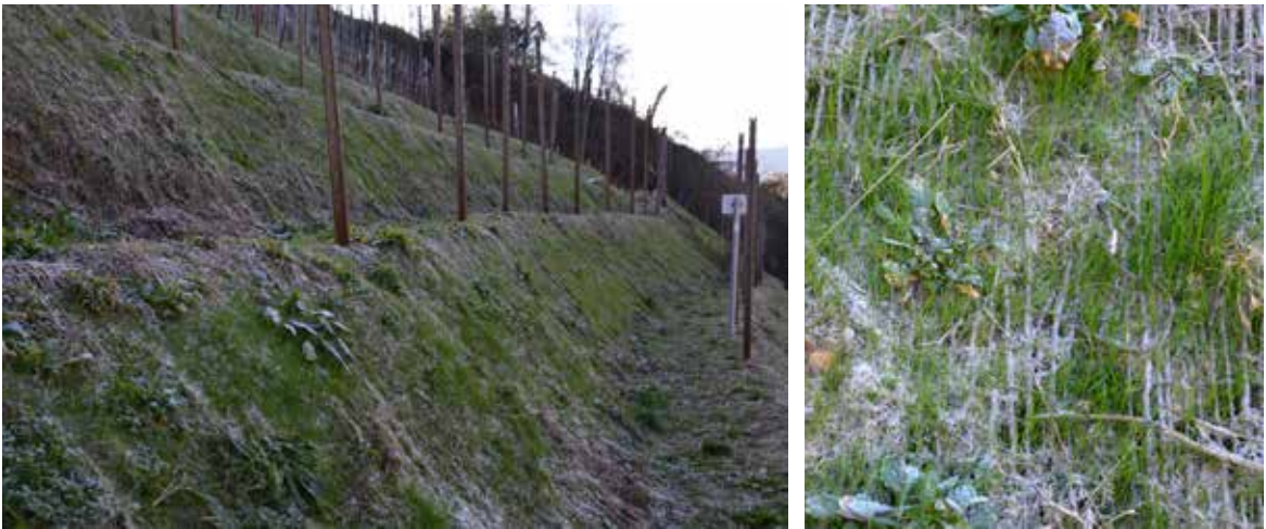
Soluzione Nesa-Maccaferri per il ripristino di microfrana nell’area Conegliano Valdobbiadene con tecnologie a basso impatto ambientale: terre rinforzate Terramesh e gabbioni. Il rivestimento Polimac consente una vita utile superiore a 120 anni, rafforzando ulteriormente il concetto di sostenibilità. Il sistema proposto Nesa-Maccaferri permette inoltre il monitoraggio continuo nel tempo dell’efficienza dell’opera tramite sistemi di diagnostica elettronica della stabilità (vedi sensore bianco su palo). Per migliorare ulteriormente la stabilità e l’impatto visivo ambientale si è provveduto ed eseguire idrosemina in modo da mascherare completamente l’intervento di ripristino (dettaglio a destra).
