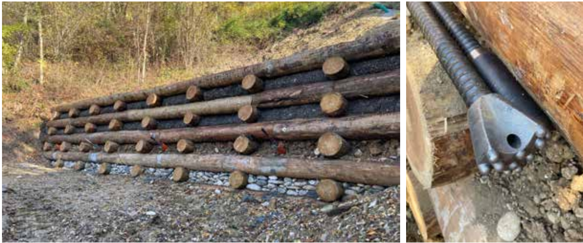
Briglia in legno ancorata con ancoraggi passivi in barra cava autoperforante (Sirive R32P a dx), nell’ambito dei lavori di messa in sicurezza di una frana sopra il Molinetto della Croda nel Comune di Refrontolo - TV (foto F.Ili Vidori Srl, 2022)
